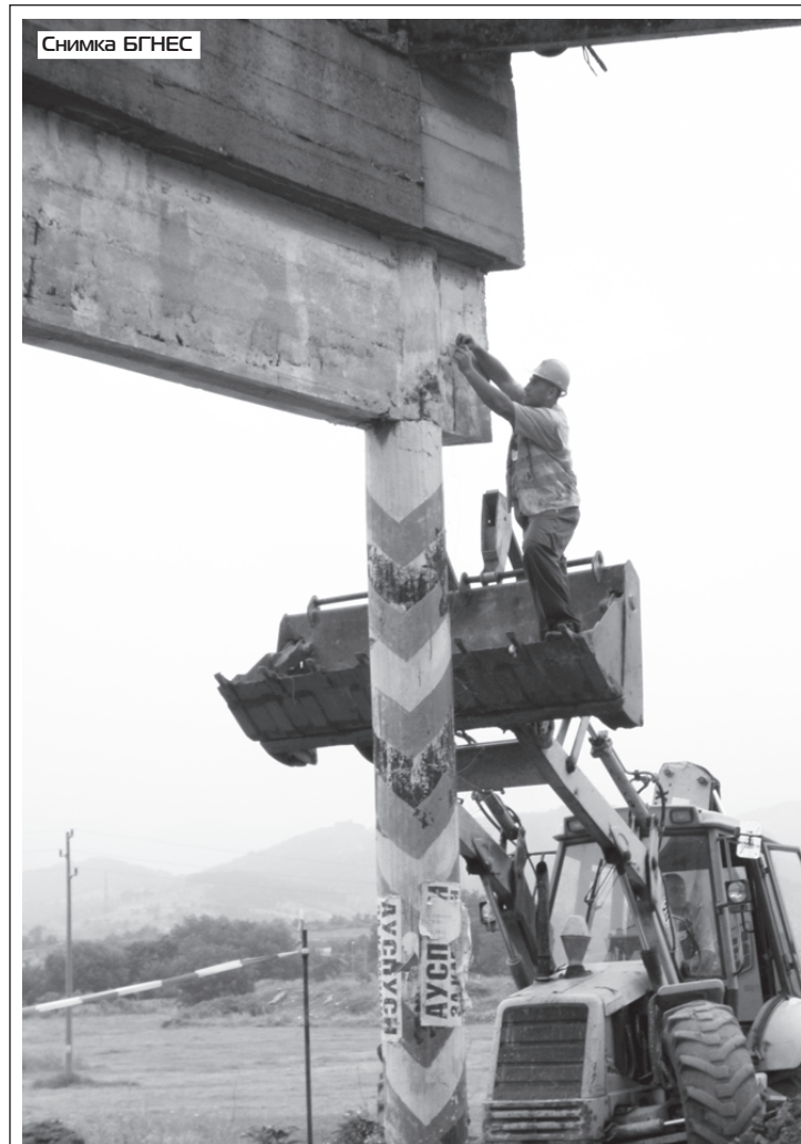
Снимка БГНЕС Седем килограма амонит заредиха в колоните на "Триумфалната арка" на Е-79 специалистите на "Експлозив инженеринг"-София, които вчера по обед взривиха пътното съоръжение край Симитли
