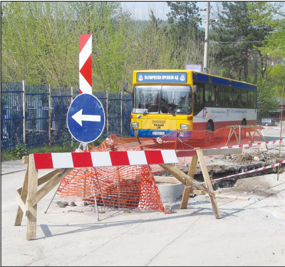
Изграждането на отводнителни шахти затруднява движението на автобуси и автомобили в района на гарата във Велико Търново
